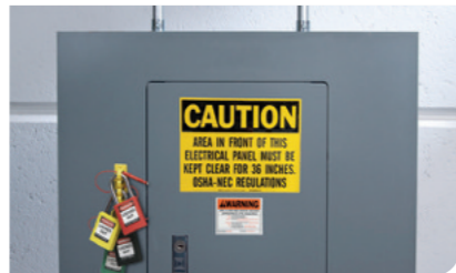
Identificatie van panelen en kasten
